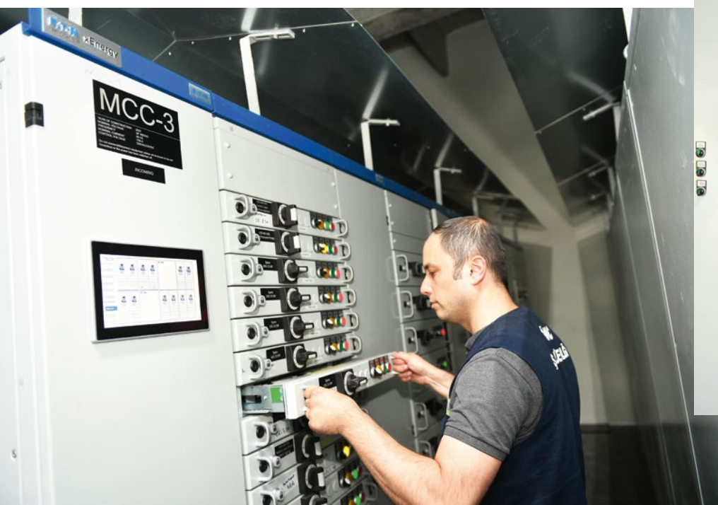
In dem Motor Control Center befinden sich Leistungsschalter von Eaton.
