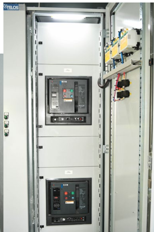
In dem Motor Control Center befinden sich Leistungsschalter von Eaton.
